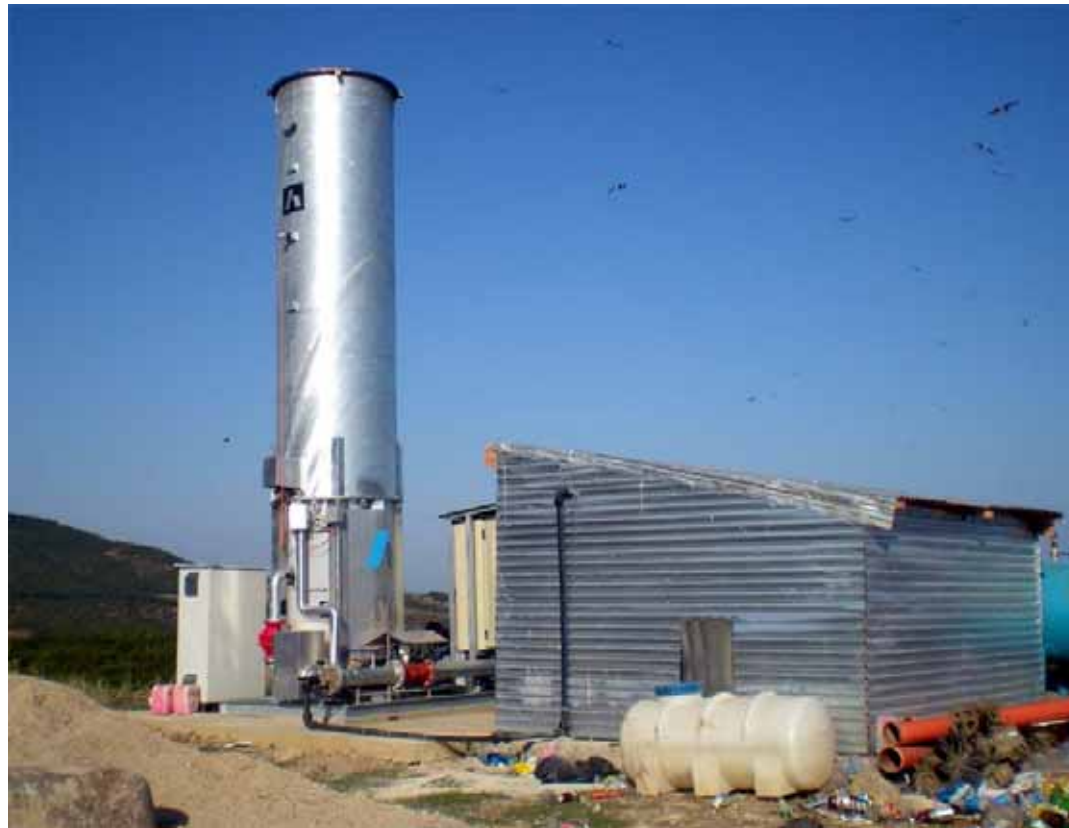
Сжигание биогаза в факеле, август 2008 (Гафса/С6 Capital/ НТЦ Биомасса)
